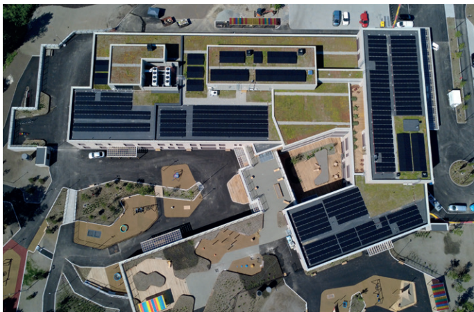
Taket har en såkalt blågrønn løsning, der det er sedumtak med fordrøyningsløsninger. Deler av taket har også solceller samt at det er solfangere på noen av veggene.
